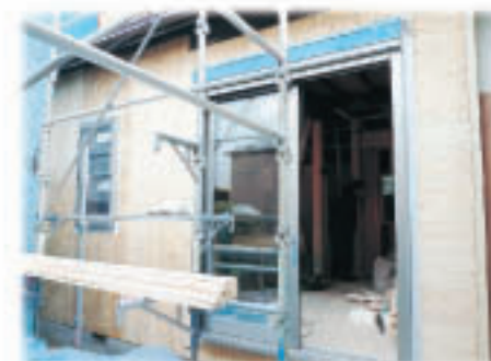
外側からも耐震補強
