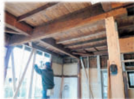
耐震補強作業中
