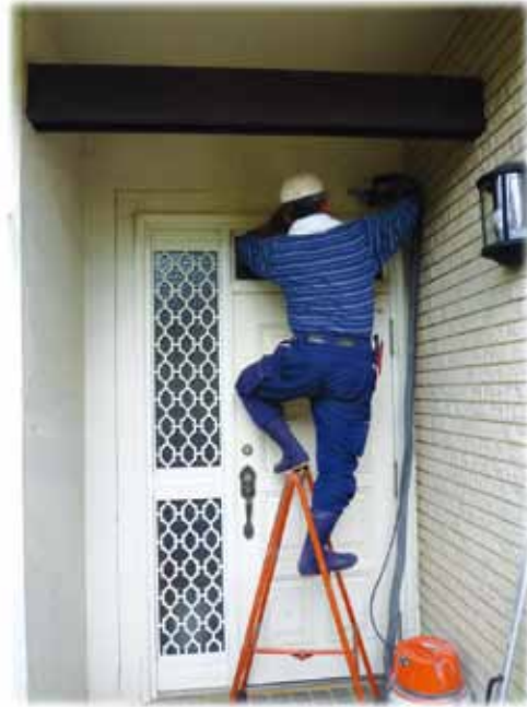
玄関の取り外し を始めます
