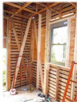
耐震補強も済み内部の仕上げに掛かる 大工さん。形が見えてきました
