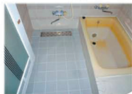
1.2mX1.6mの冬寒い戸建の浴室 (タイル貼り) 施工前
