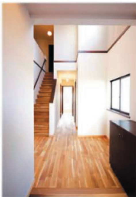
玄関はナラ無垢材貼りじゅうたん だった階段もナラ無垢材が貼りました
