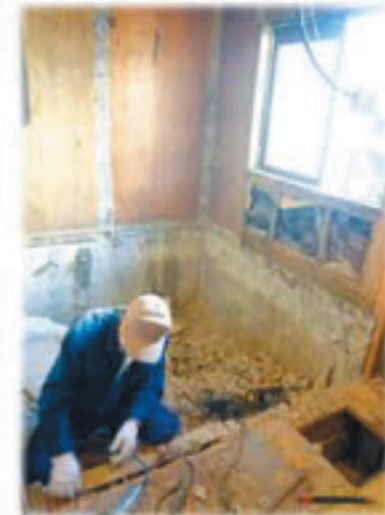
浴室を大きく取るため 基礎の一部を壊して 1.6mX1.6mのユニットバスに
