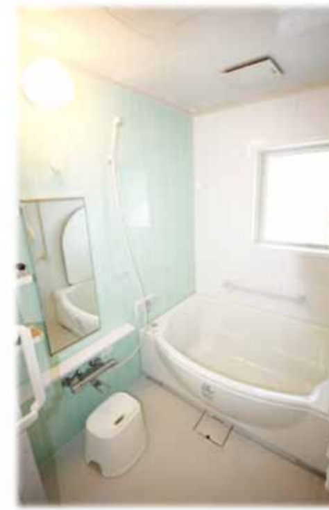
タイル貼りの寒いお風呂から暖かいユニットバスへ、サイズも1216(0.75坪)から10センチサイズアップして1317サイズ入、この10センチのサイズアップで足が伸ばせるようになりました
