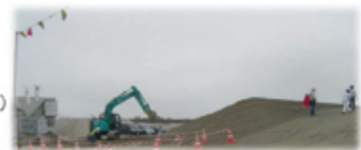
高さ上げ工事 (玉浜田地区造成工事)
