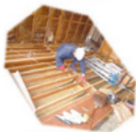
2階居間の床を補強
