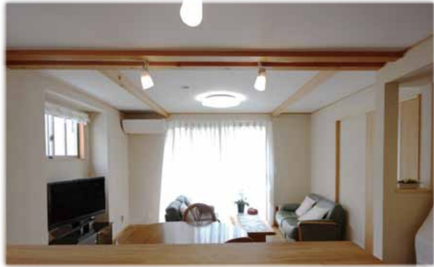
チークムク板(床材)の居間 珪藻土の壁
