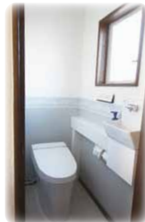
新しく手洗いを取り付け 奥行65cmのコンパクトな トイレに! 広くなりました
